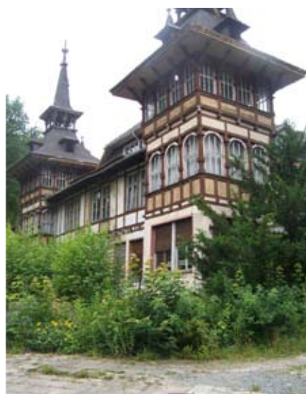
Denkmäler im Dornröschenschlaf: Bahnhof und Eisenbahnerheim in Alexisbad. Der Damm Straßberg ermöglicht Planungs- sicherheit für künftige Nutzung.
