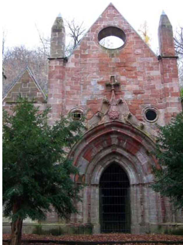
Das Mausoleum, 1832 erbaut, diente als Begräbnisstätte der Grafen von der Asseburg-Falkenstein.
